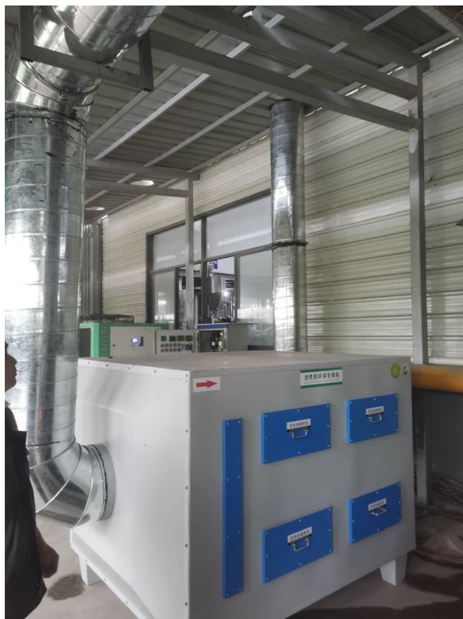
图 3.2-3 成型废气活性炭吸附装置
