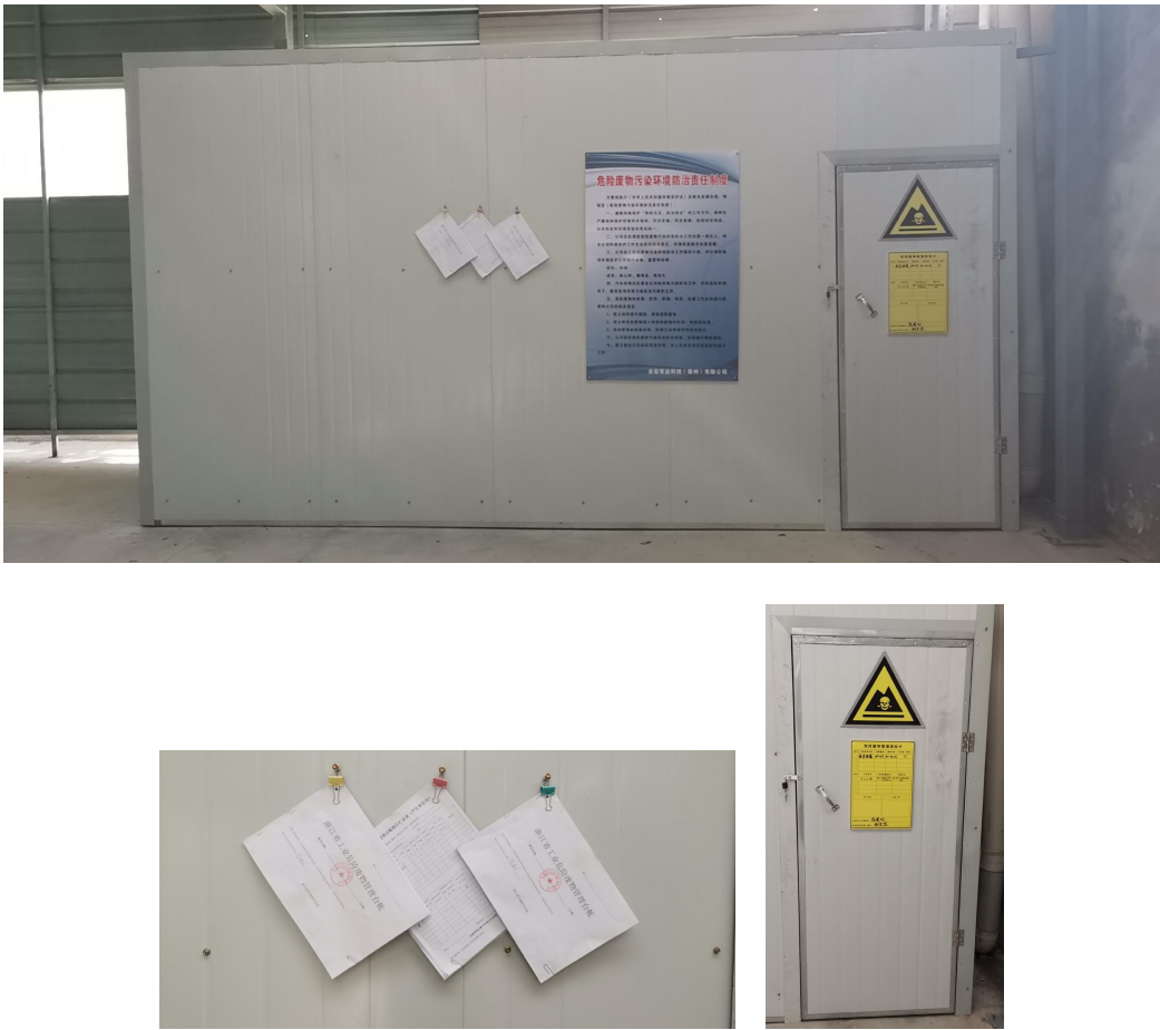
图3.4-1 危废暂存间现场照片
