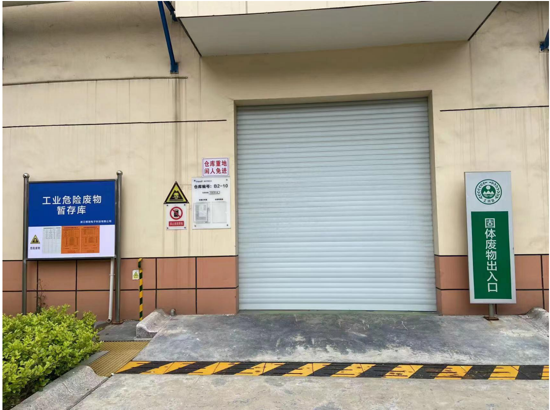
图 10-3 企业危废暂存间
