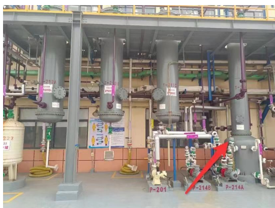
纯化、充装废气处理设施 (箭头所指设施)
